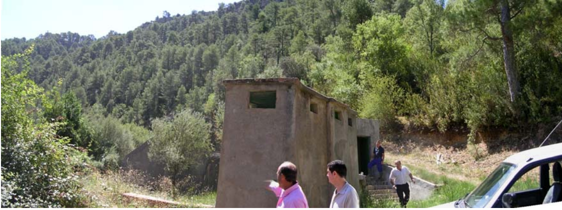
Foto 1.- Vista general de la captación de Rojo Frío
